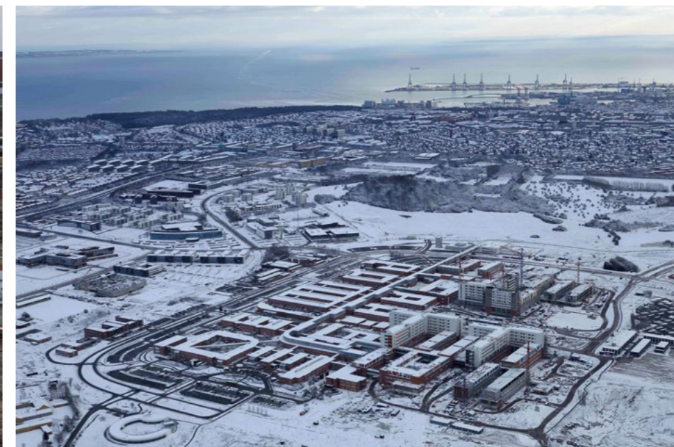
Aktuell wird an vielen Stellen noch gebaut, aber schon im Sommer 2015 werden die ersten Patienten in einem der Neubauschnitte behandelt
